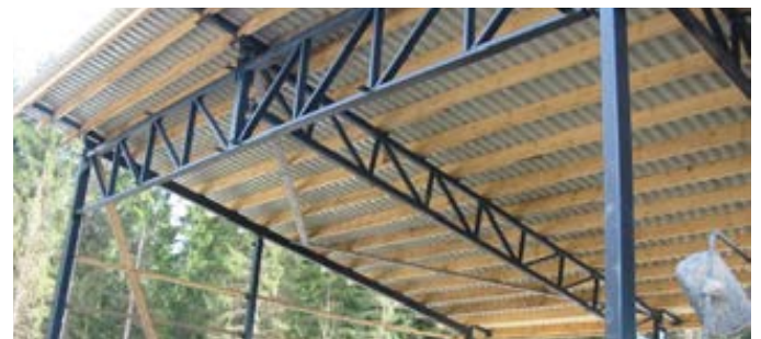
Weckman maskingarage finns tillgänglig med bredare portöppning. En horisontell fackverksram ersätter en vertikal pelare.
