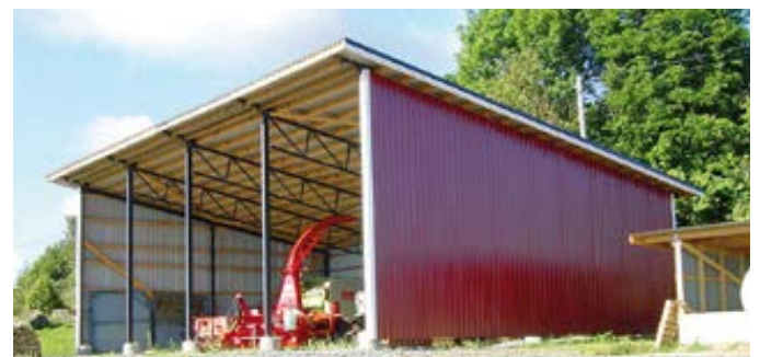
Weckman maskingarage finns tillgänglig med bredare portöppning. En horisontell fackverksram ersätter en vertikal pelare.
